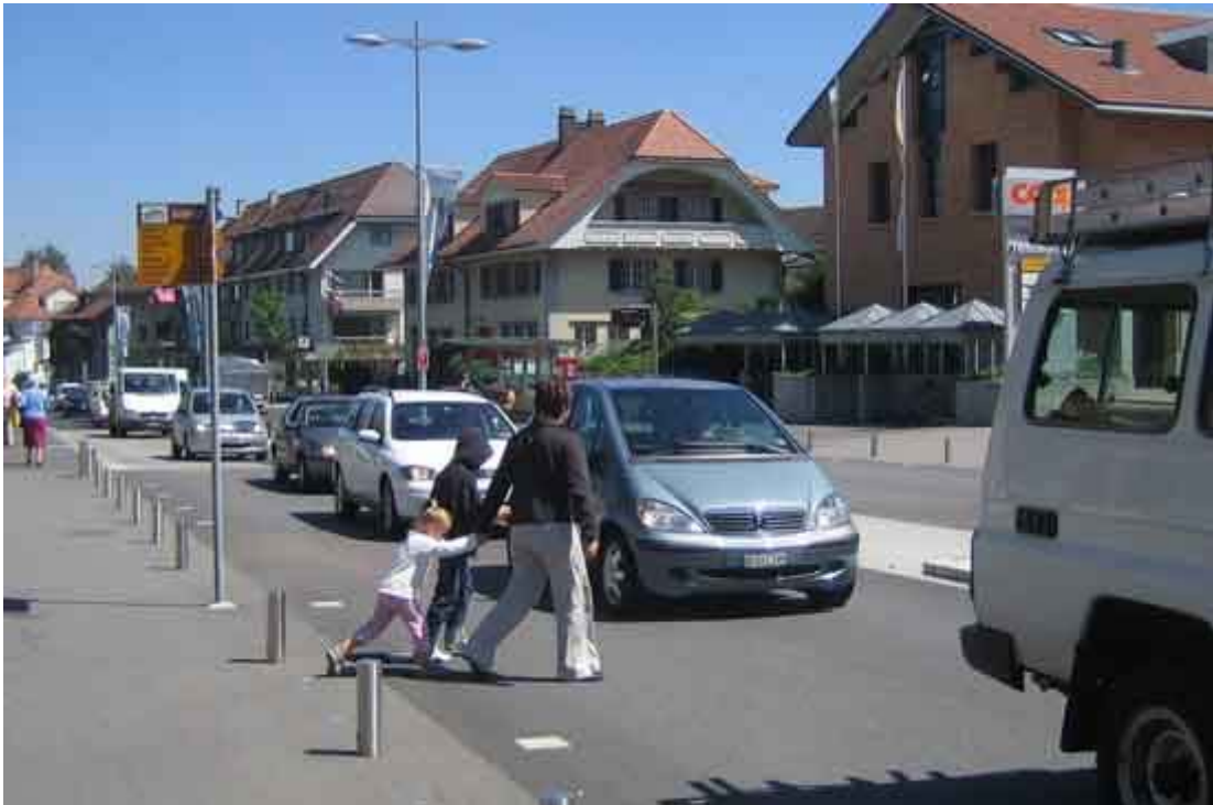
Bild Köniz: Tempo 30, Fahrbahnbreite 4.30 Meter, Verzicht auf Fussgängerstreifen, genügend Raum für Velofahrende, daher Verzicht auf Velostreifen.
